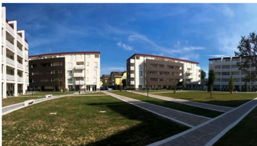
Il nuovo polo "Qui Padova"
